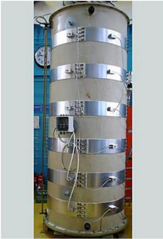
Kessel vor Isolation mit sichtbaren Anlegeheizungen
